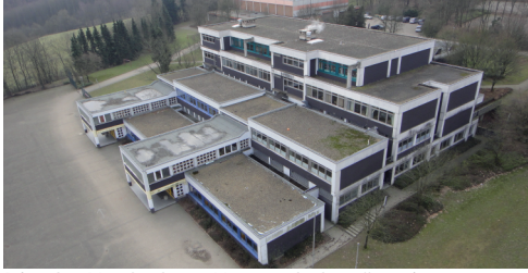
Die alte Hardenberg-Hauptschule wäre ein geeigneter Standort für eine zweite städtische Gesamtschule (Foto: M.G.)
